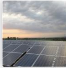
Ergolding, Munchen, DE 1,420 MW
