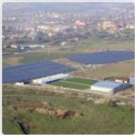
Nazna, Mures, RO 2,5 MW
