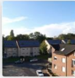
Bottrop 2, DE 1,5 MW
