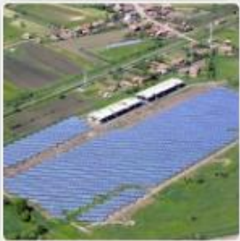
Ghindari, Mures, RO 2,5 MW
