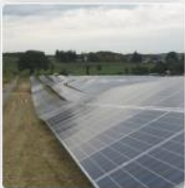
Jichisu de Jos, Cluj, RO 5,8 MW
