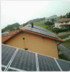
Bottrop, DE 1,3 MW
